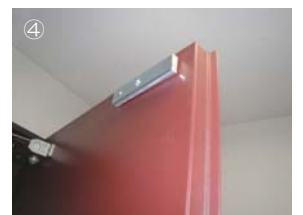
④ スチールドアに吸着板 外開きなので扉に吸着板を取り付ける。内開きならLZ金具を扉に取り付けてそのLZ金具に吸着板を取り付ける。
