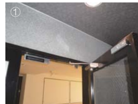
① アルミドアへの標準的な設置例 EM280(280kgタイプ)を取り付けました。
