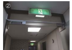
② 強化ガラスドアへの設置例 電磁石錠は左右の壁に固定した角パイプに取り付けました。
